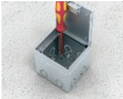
Asennus raakaväliin Lattiarasia kiinnitetään raakaväliin.
