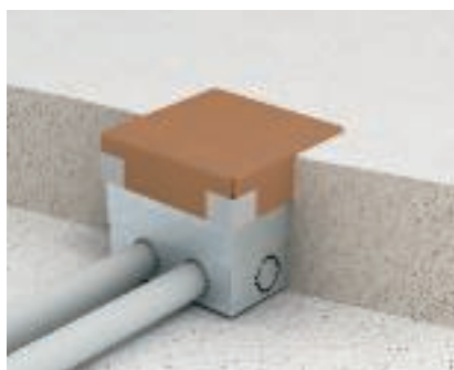
Valutyöt Pintalattia valetaan valurasiaan yläreunaan asti. Valun ja rasian välissä ei käytetä eristettä.
