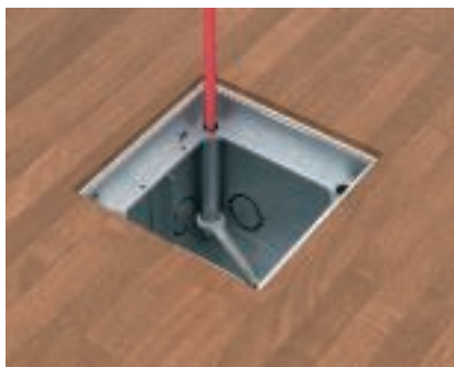
Säätö valmiin lattiatasalle Korkeus säädetään ja säätöruuvit varmistetaan vastamutterilla.
