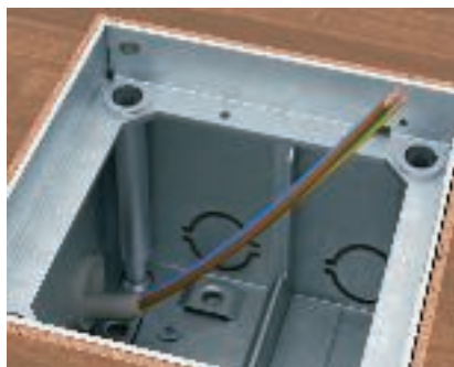
Kaapelin valmistelu pistorasiaan asennusta varten Kaapeli kuoritaan sopivan mittaiseksi
