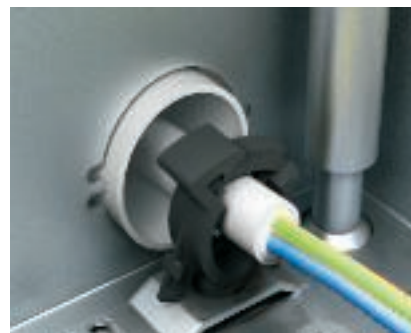
Vedonpoistimen asennus Vedonpoistin sijoitetaan asennetun asennusputken eteen (pistorasian kytkentää varten).
