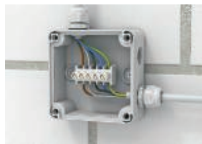
Kytentälaatta Jakorasiaan voidaan asentaa kytentälaatta.
