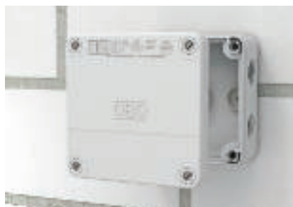
Kannen asennus Kansi kiinnitetään rasiin.
