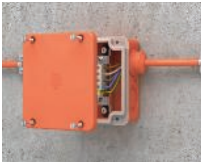
Asennuksen päättäminen Kannen kiinni ruuvaaminen.
