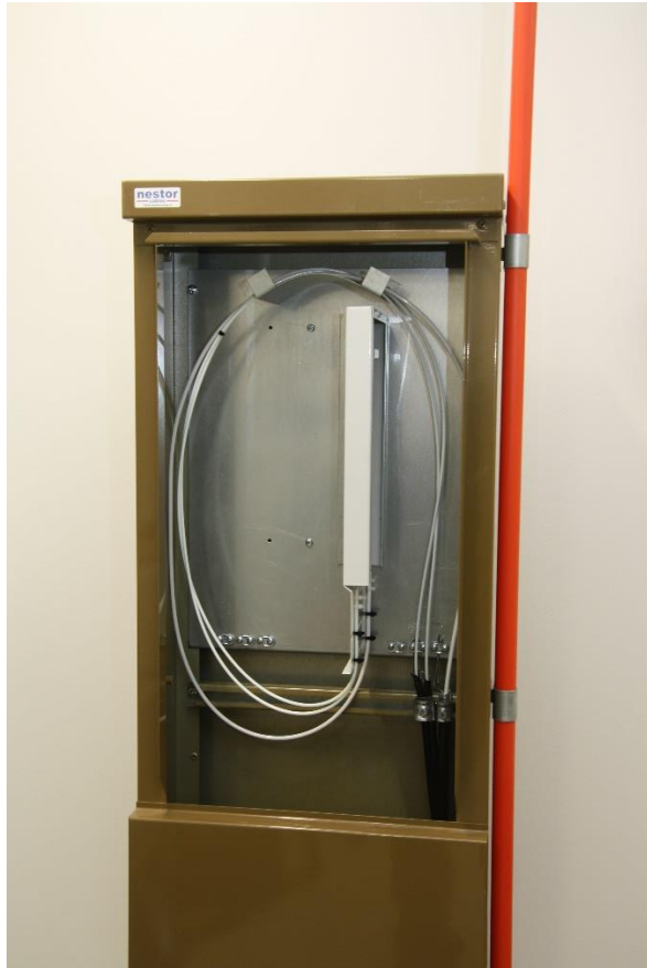
FYOVD2PMU-maakaapeli ja kaksi FYO2PMU Mini -talokaapelia asennettuina jatkoskaappiin
