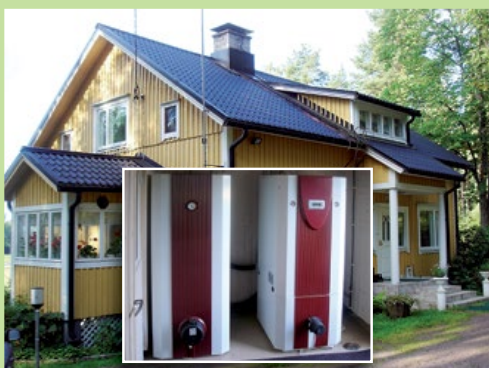
Öljykattila vaihdettiin maalämpöpumppuun SIKH 9 TE
