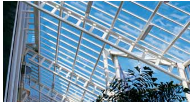
Kylmävedon kompensointi hotellin aulassa
