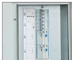
Lähtöjen nimikoinnit ovat keskuksissa valmiina.
