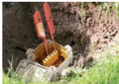
Kovettunut joustava geeli antaa vedenpitävän suojan – IP68. Geeli toimii myös johdinten vedonpoistimena. Sähkömittaukset voidaan tehdä geelin läpi – se tiivistyy itsestään.
