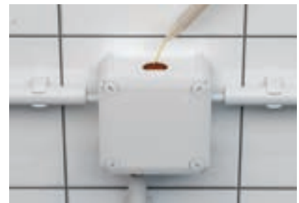
Helppokäyttöinen: Jakorasiin eristäminen kaapeliaihion kautta.
