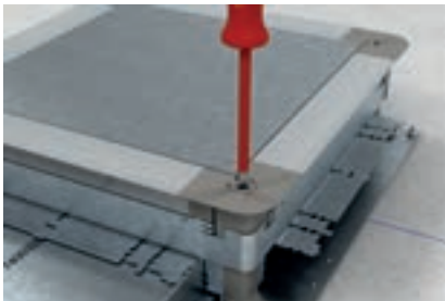
Valurasia säädetään samalle tasolle kuin tuleva pintavalu. Hienosäätö voidaan tehdä vielä kun valu ei ole täysin kovettunut.
