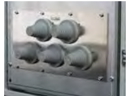
Kaapeleiden läpivienti erotusseinän läpi TS 8 kaapissa moduulilevyä hyödyntäen.
