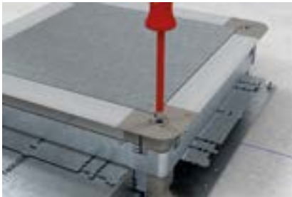
Valurasia säädetään samalle tasolle kuin tuleva pintavalu. Hienosäätö voidaan tehdä vielä kun valu ei ole täysin kovettunut.
