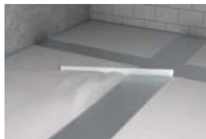
Lattiakanavan reunaprofiileihin asennetaan valuankkurit ja pintavalu valetaan lattiakanavan kanssa samalle tasolle.
