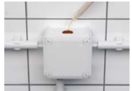
Helppokäyttöinen: Jakorasian eristäminen kaapeliahion kautta.
