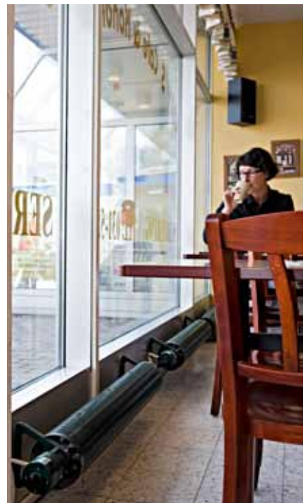
Ripaputkilämmitin on muotoilunsa ja kannakkeiden ansiosta helppoa asentaa esim. ikkunan alle.
