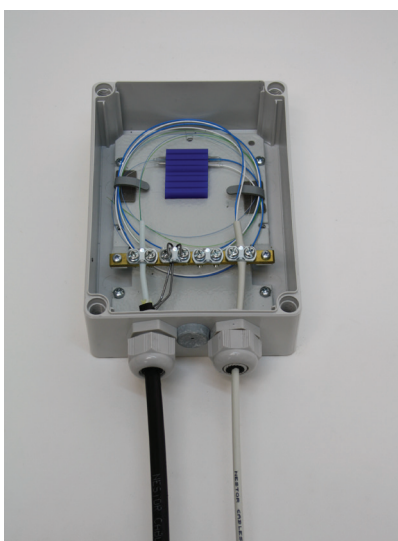
Ulkopäätetekotelo NC-140 asennettuna
