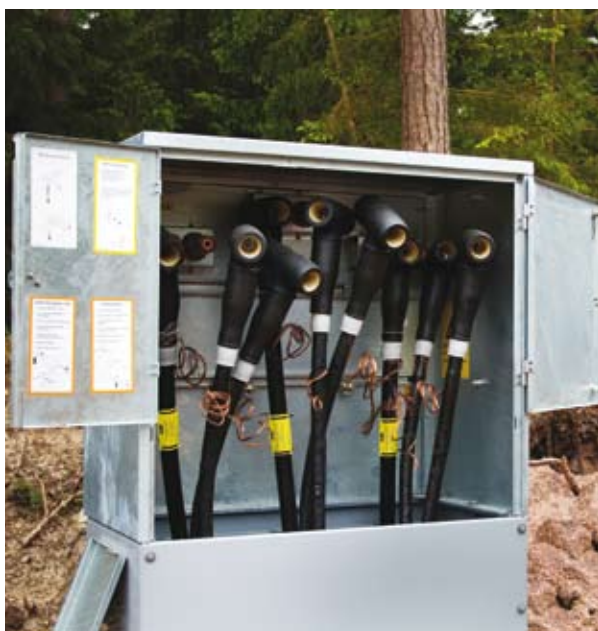
Kabeldon-kaapelijakokaappi, 36 kV.
